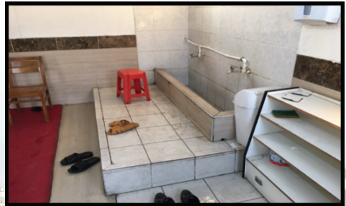
Şekil 51: Metro Susurluk Dinlenme Tesisi Mescit Abdesthanesi
