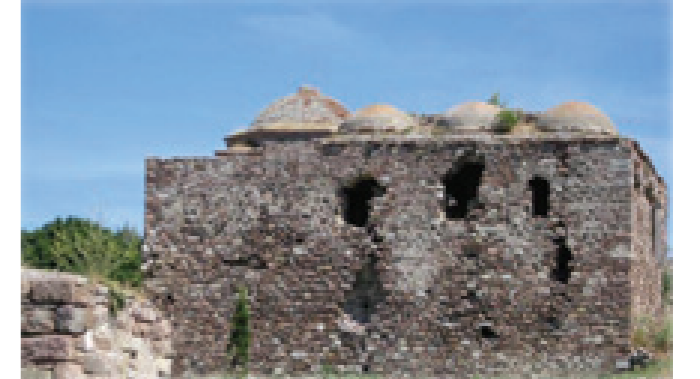
Şekil-75: Veli Paşa Medresesi'nden görünüm.
