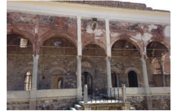
Şekil-23: Ön cepheden görünüşü.
