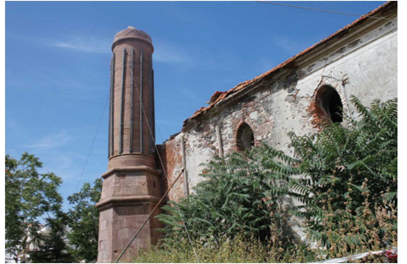
Şekil-29: Valide Camii.
