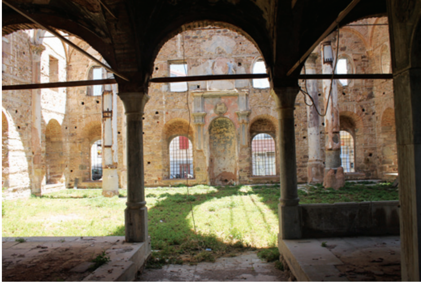
Şekil-1: Yeni Cami içten görünüş
