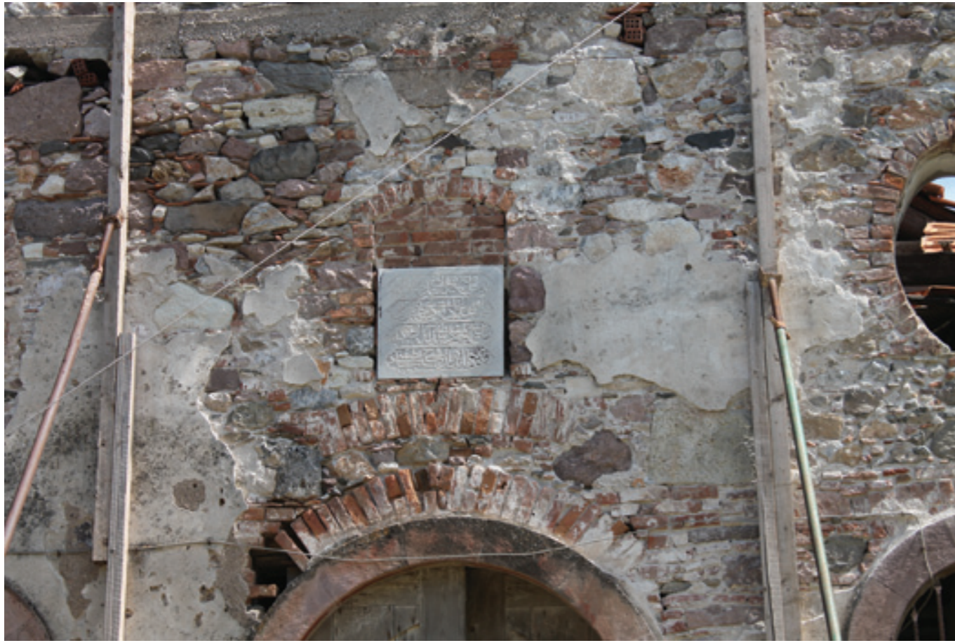
Şekil-31: Valide Camii.
